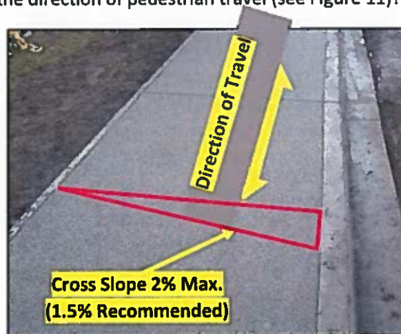
Figure 11: PAR Cross Slope
